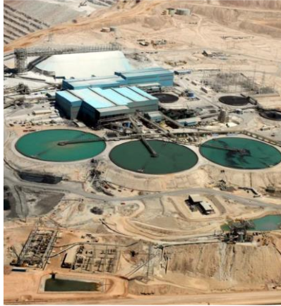
รูปที่ ๔ โรงแต่งแร่ Los Colorados ที่แต่งแร่จากเหมือง Escondida ของบริษัท BHP
