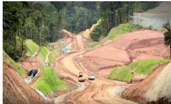
ภาพการก่อสร้างโครงสร้างพื้นฐานของเหมือง Cobre Panama เมื่อเดือนเมษายน ๒๕๕๖
