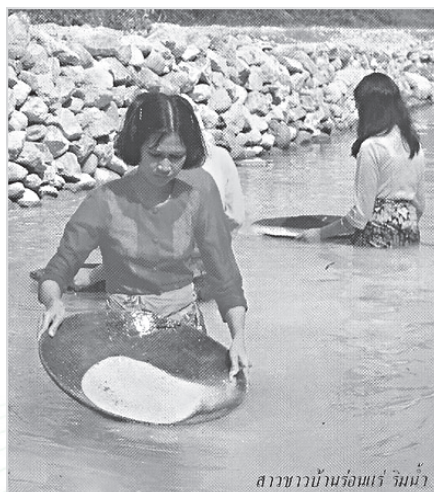
รูปที่ 2 การร่อนหาแร่ดิบของชาวบ้านโดยใช้เลียงร่อนแร่
