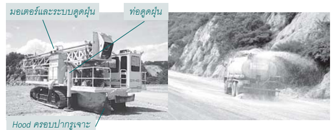
การขุดเจาะระเบิดโดยมีระบบป้องกันฝุ่น
