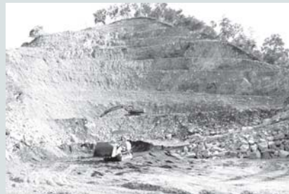
การปรับปรุงพื้นที่ให้เป็น ชั้นบันได
