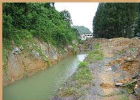
คูระบายน้ำลงสู่บ่อดักตะกอน
