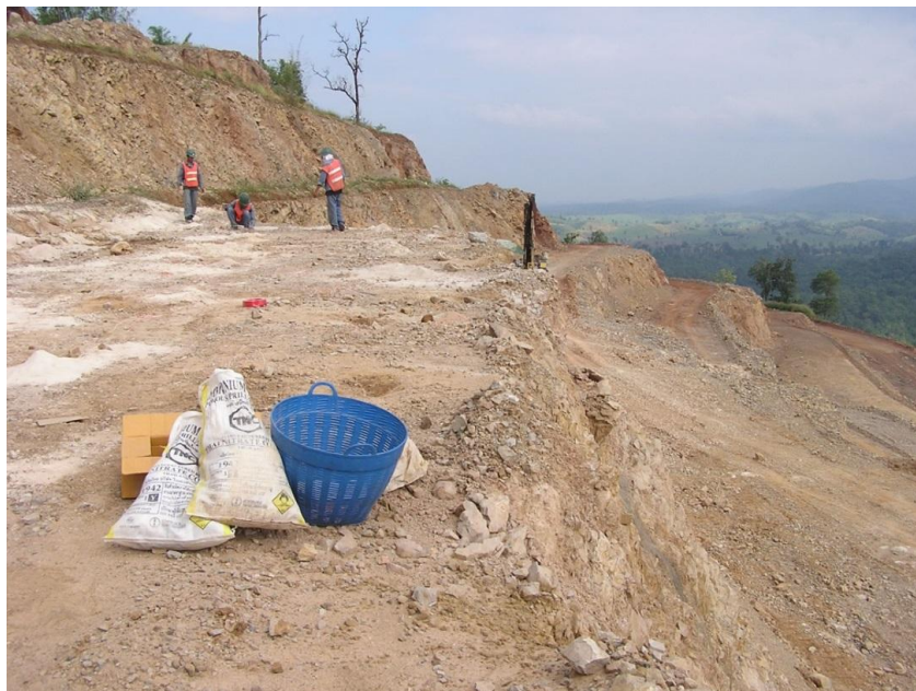
รูปที่ 6.4.2 เชื้อปะทุและดินระเบิดที่เหลือจากการอัดระเบิด นำมารวมกันและเตรียมขนกลับไปพร้อมกัน
