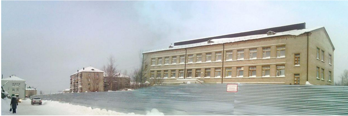
รูปที่ 6.6.10 เขตอันตรายโซน 8 จากซ้ายไปขวาอาคารที่ว่าการเมือง และบ้านเลขที่ 1 บนถนน Maxim Gorky มีการอพยพคนออกจากอาคารที่ว่าการเมือง เมื่อวันที่เดือนกรกฎาคม 2013 (ที่มา: ru.wikipedia.org)
