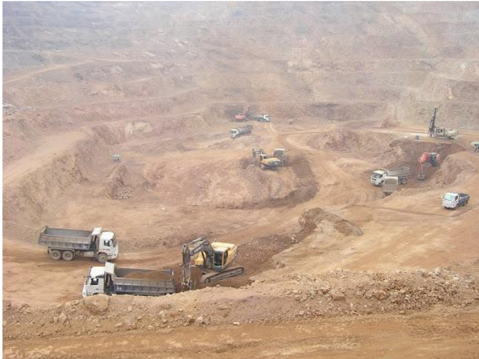
รูปที่ 4.8.3.2 ห้ามอัคระเปิดไปด้วย เจาะไปด้วย ขนไปด้วย ทำรั้วหน้าเหมืองไปด้วย
