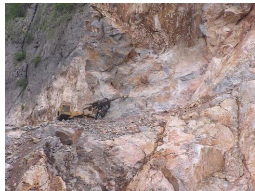
รูปที่ 2.4.1 การระเบิดตัดฐานชะง่อนหิน
