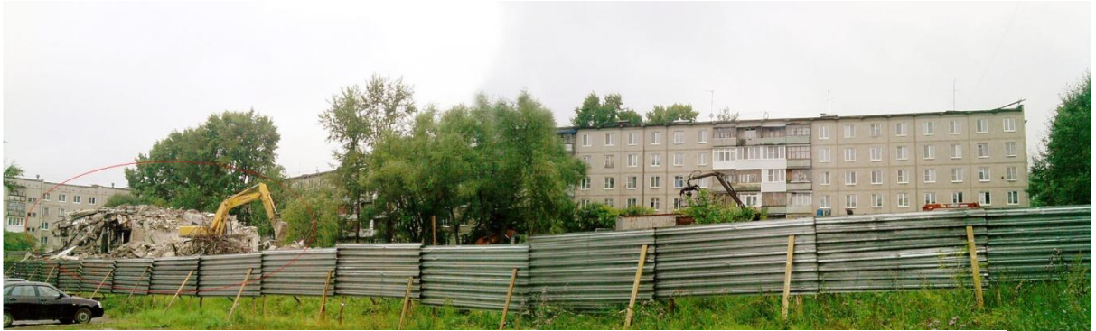
รูปที่ 1.8.12 วันที่ 20 สิงหาคม 2012 การทำลายอาคารหมายเลข 38 บนถนน world ในวงกลมสีแดง ด้านหลังเป็นอาคารเลขที่ 40 (ที่มา: ru.wikipedia.org)
