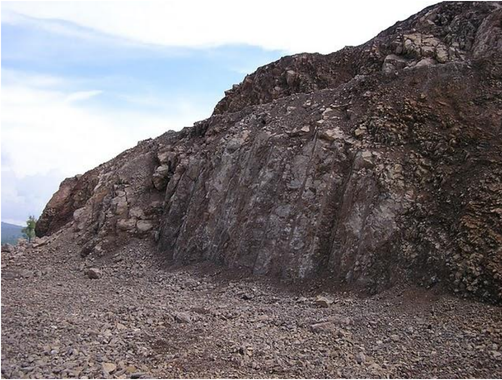
รูปที่ 4.5 .7 แสดงผลที่ได้จากการเจาะระเบิดแบบ pre-splitting
