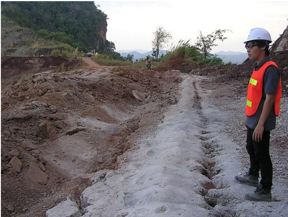
รูป 4.5.8 แสดงผลที่ได้จากการเจาะระเบิดแบบ line-drilling
