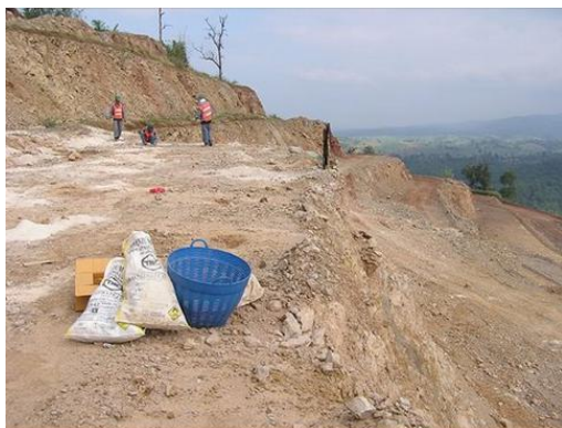
รูปที่ 4.8.3 .4 ห้ามขนเชื้อปะทุและดินระเบิดไปรดกันเดียวกัน
