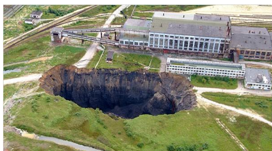
รูปที่ 1.8.1 หลุมยุบที่เกิดจากน้ำท่วมเหมือง (ที่มา www.therichest.com )
