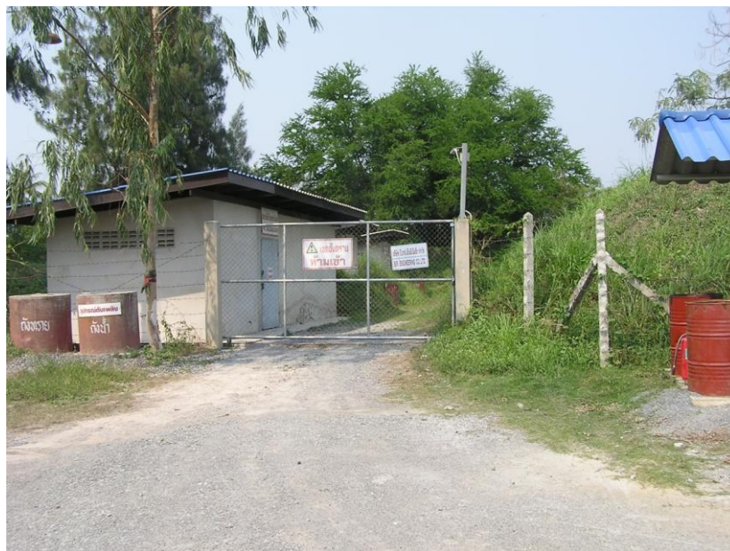
รูปที่ 4.8.2 คลังเก็บวัตถุระเบิดที่สร้างผิดหลักการความปลอดภัย
