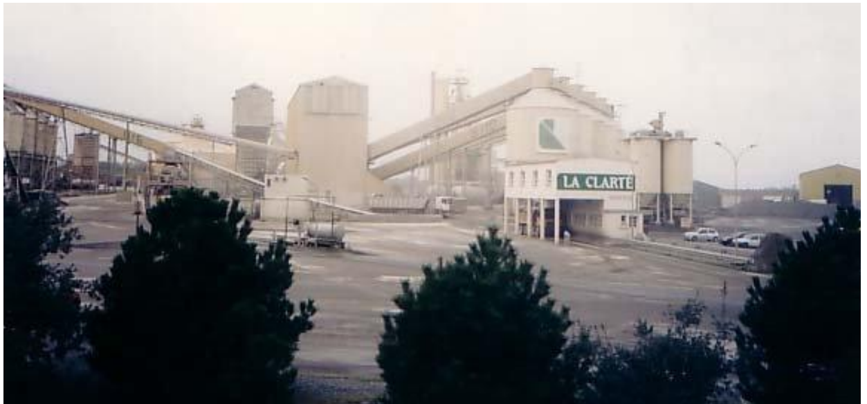
รูปที่ 1.6.2 โรงโม่หินของบริษัทลาคลาร์ท์ (La Clarte) ทางตอนใต้ของประเทศฝรั่งเศส
