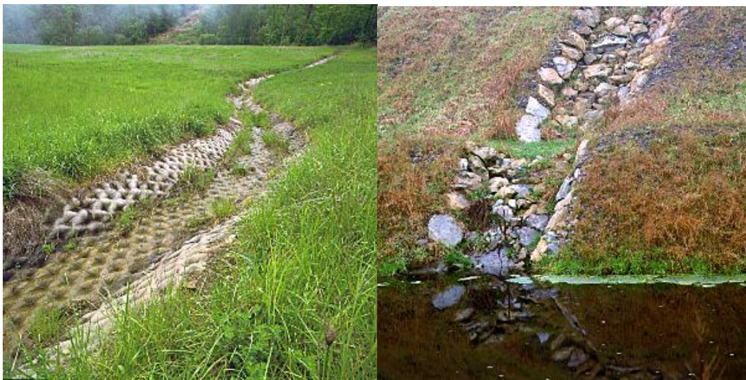
ภาพแสดงการควบคุมการกัดเซาะหน้าดินโดยใช้พืชคลุมดิน คอนกรีต และก้อนหิน
