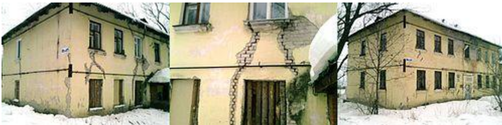
รูปที่ 1.8.10 รอยแตกของอาคาร (Mendeleev 1) และอาคาร Stepanova อยู่ห่างจากโรงเรียน นานาชาติออกไปประมาณ 50 เมตร (ที่มา: ru.wikipedia.org)
