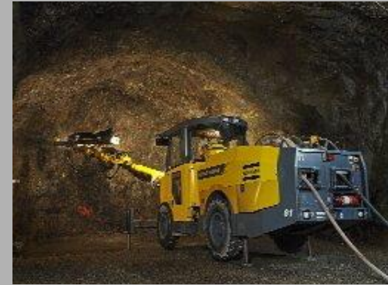
เครื่องเจาะยี่ห้อ Atlas Copco ติดตั้ง หัวเจาะรุ่น COP 1440
