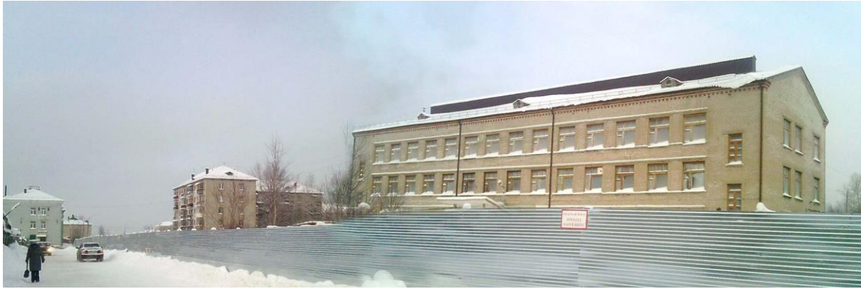
รูปที่ 7.6.10 เขตอันตรายโซน 8 จากซ้ายไปขวาอาคารที่ว่าการเมือง และบ้านเลขที่ 1 บนถนน Maxim Gorky มีการอพยพคนออกจากอาคารที่ว่าการเมือง เมื่อวันที่เดือนกรกฎาคม 2013 (ที่มา: ru.wikipedia.org)
