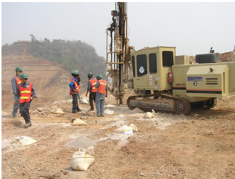
รูปที่ 7.4.3 คนขับรถเจาะผู้มีความสามารถในการขับรถเจาะหลบแก๊ปไฟฟ้าและแท่งดินระเบิด
