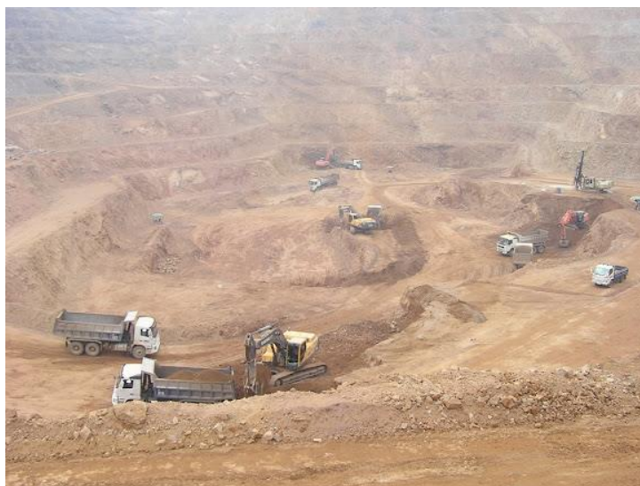
รูปที่ 7.4.1 การอัดระเบิดโดยไม่เคลื่อนย้ายคนงานและเครื่องจักรไปไว้ในที่ปลอดภัยเสียก่อน
