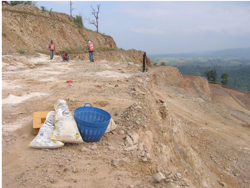
รูปที่ 7.4.2 เชื้อปะทุและดินระเบิดที่เหลือจากการอัดระเบิด นำมารวมกันและเตรียมขนกลับไปพร้อมกัน
