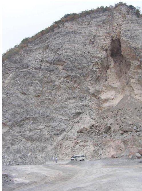
รูปที่ 7.3.2 หน่วยงานอยู่ใกล้หน้าผาที่สูงชันเนื่องจากการอนุญาตประทานบัตร เพียงครึ่งภูเขา
