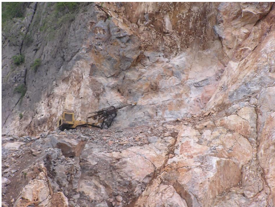
รูปที่ 7.4.5 การเจาะระเบิดตัดฐานเป็นรูปพัดโดยการระเบิดออกเป็นแผ่น ๆ ในแนวตั้ง
