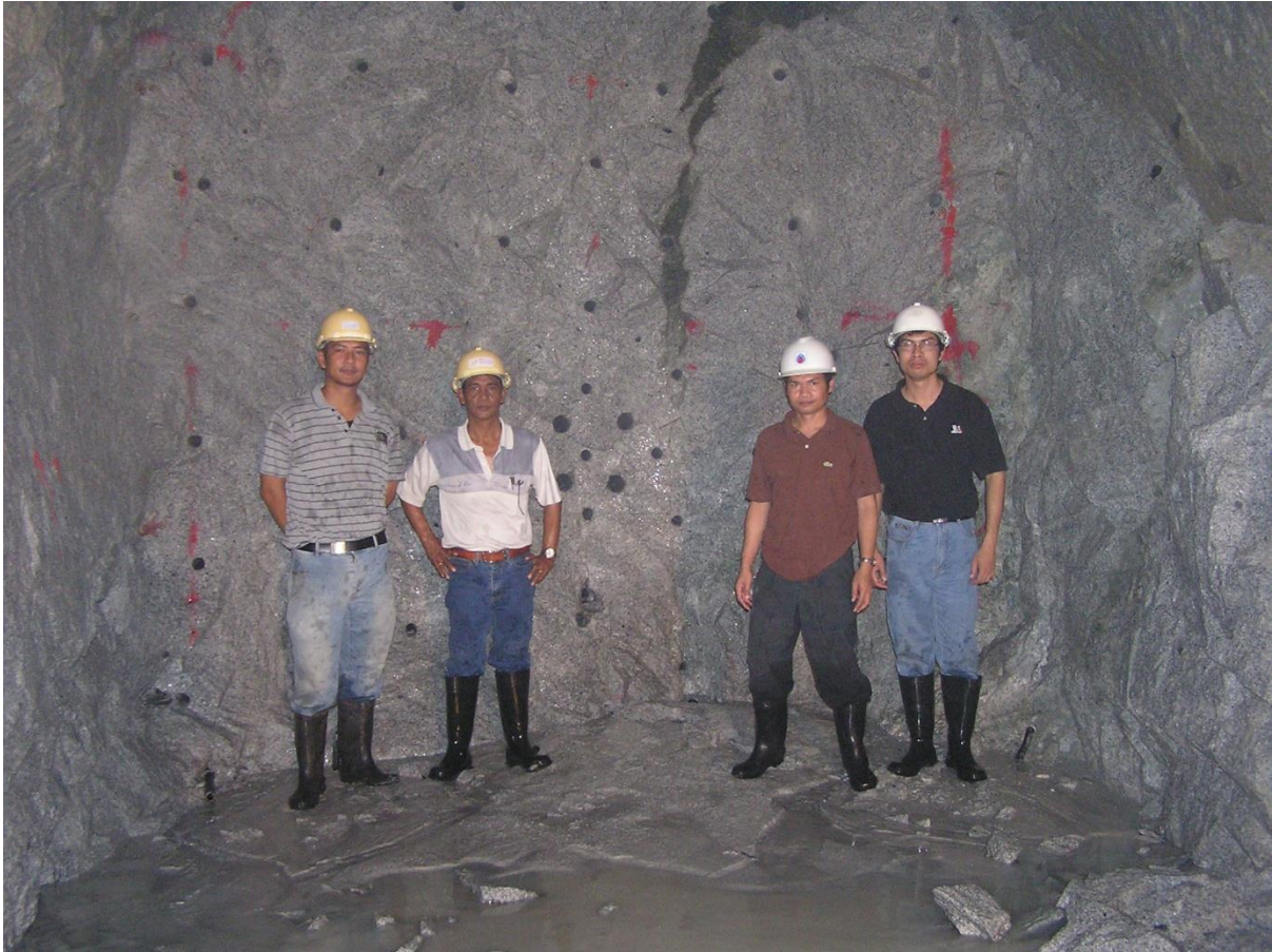
รูป 2.1.14 แสดงการเจาะรูระเบิดขนานกับแนวอุโมงค์ (Burn cut) ในการเจาะอุโมงค์ผันน้ำโครงการก่อสร้างเขื่อนไฟฟ้าพลังน้ำ คลองทุ่งเพล อำเภอเขาคิชฌกูฏ จังหวัดจันทบุรี
