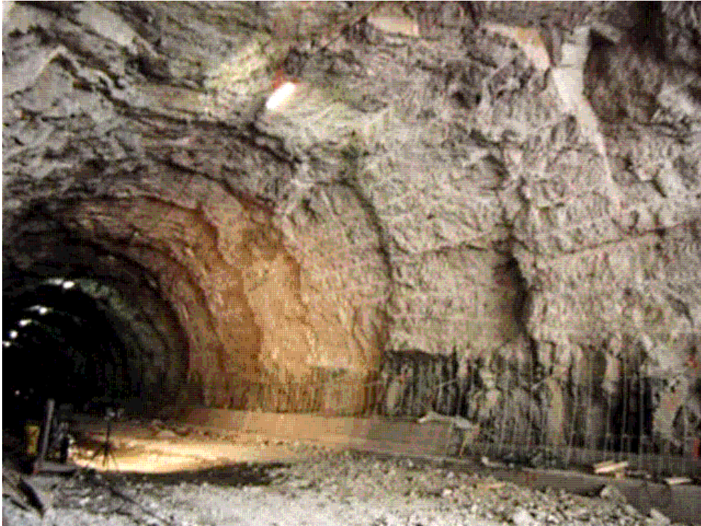
รูปที่ 2.1.17 อุโมงค์รถยนต์ปรากฏเป็นรูปเปลือกหอยพัด(Scalloping effect) ที่ผนังอุโมงค์เนื่องจากการเจาะระเบิดเพื่อการทำผนังอุโมงค์เรียบ (Smoothwal Blasting)
