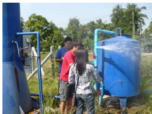
รูปที่ 2 การเก็บตัวอย่างน้ำจากบ่อประปาบาดาล
