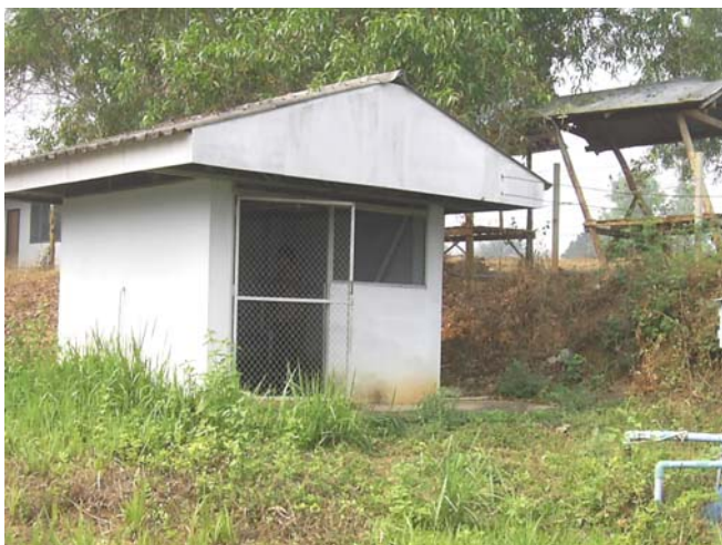
รูปที่ 4 ประปาชนบทที่ บ้านม่วงเนิ้ง
