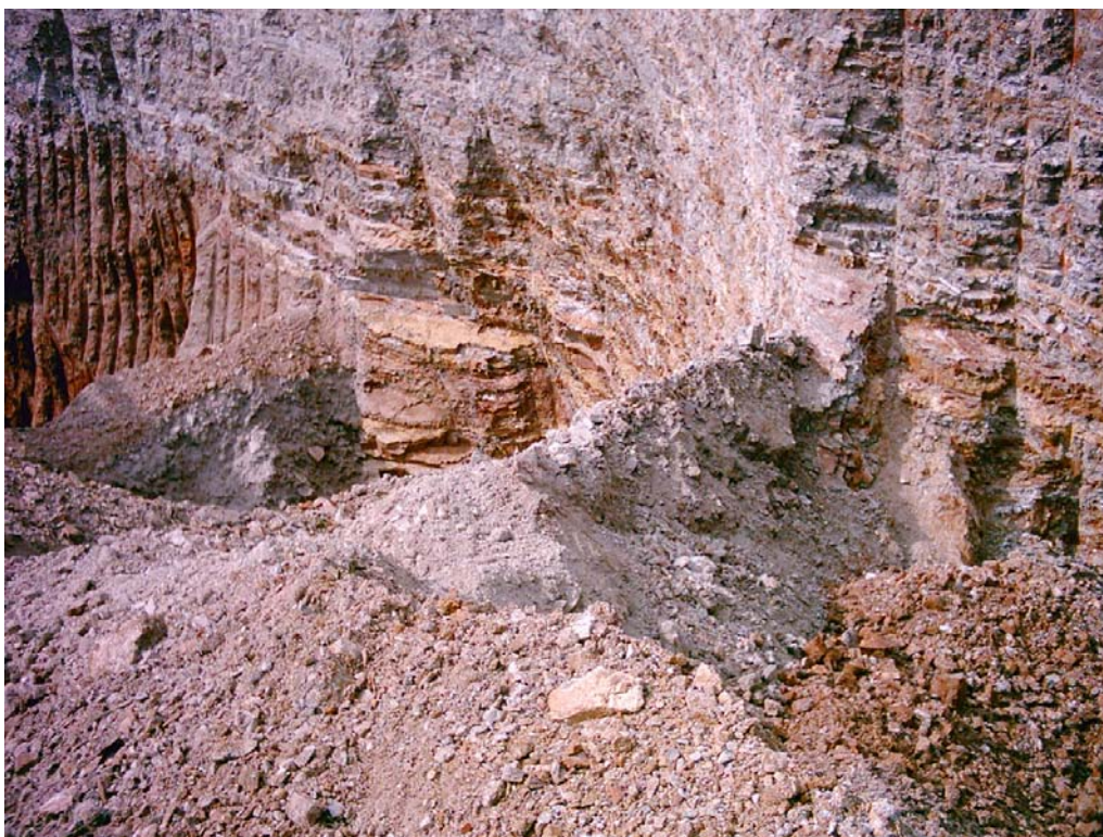
รูปที่ 7 กองดินที่ขุดกองเตรียมขนย้าย
