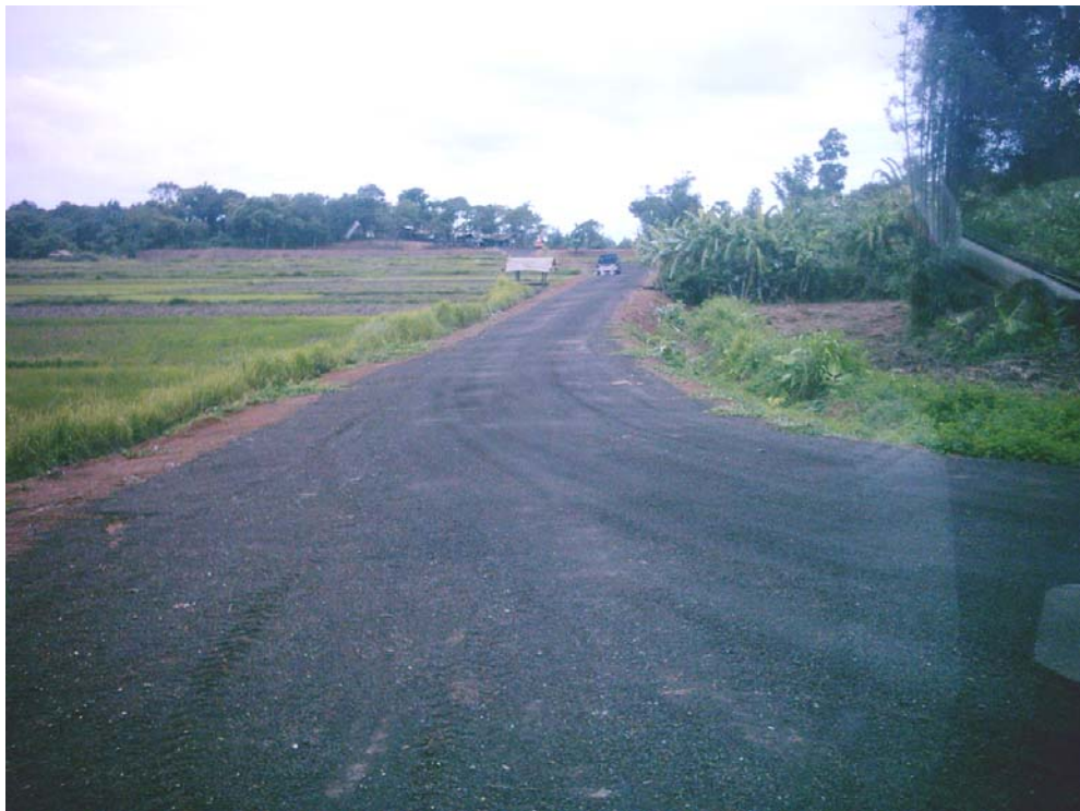
รูปที่ 2 ทางแยกเข้าโครงการฯ (ทางหลวงหมายเลข 1152 กิโลเมตรที่ 43 + 100 เมตร)
