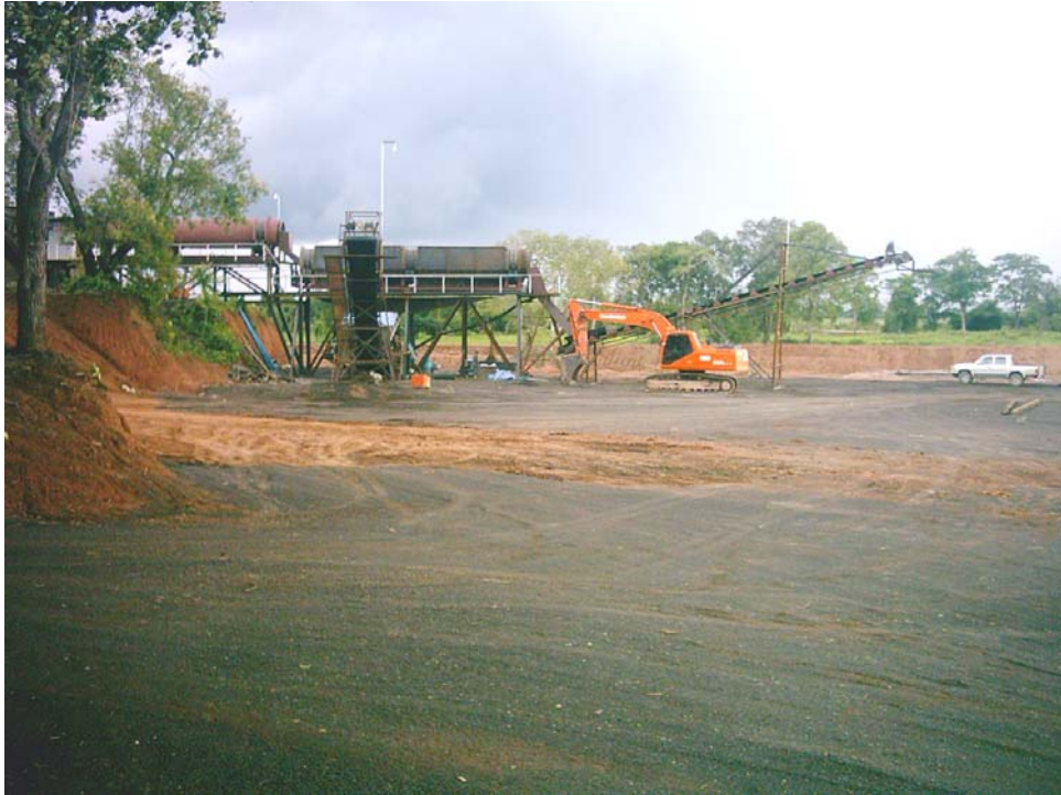
รูปที่ 4 เครื่องล้าง-คัดขนาดแร่ที่กำลังติดตั้ง
