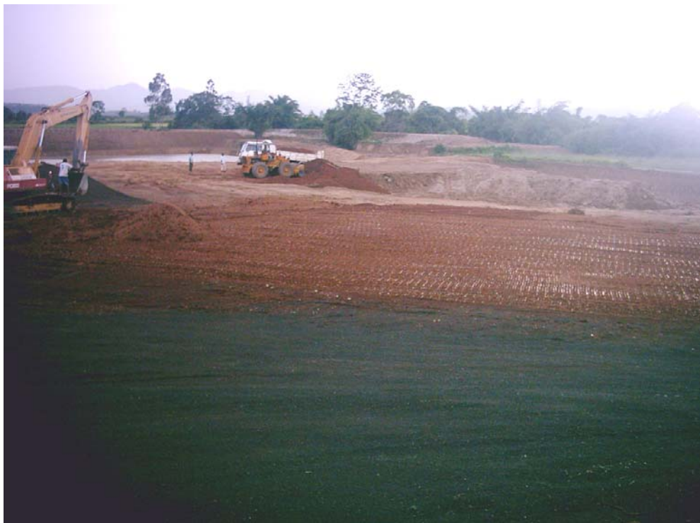
รูปที่ 3 ด้านหน้าสำนักงานเหมืองที่กำลังถมขุมเหมืองแร่เดิมเพื่อปรับสภาพพื้นที่
