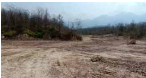
ภาพที่ 2 สภาพพื้นที่หลังดำเนินงานปรับพื้นที่
