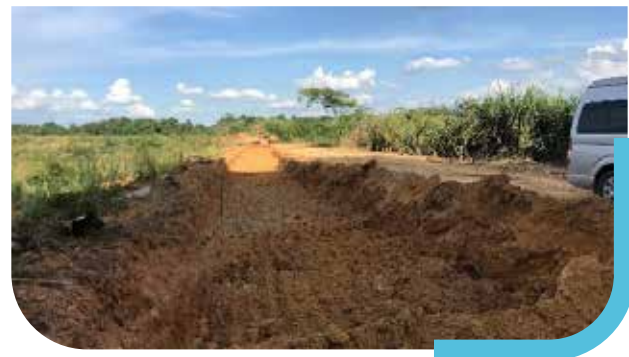
ปรับปรุงสภาพพื้นที่ทางกายภาพบริเวณสันเขื่อน บ่อกักเก็บกากแร่ที่พบการกัดเซาะ
