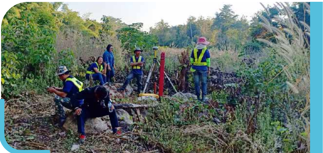
การจัดสร้างสถานีควบคุมการรังวัดบนพื้นหลักฐานสากล WGS 1984 โดยใช้เครื่องรับสัญญาณดาวเทียม
