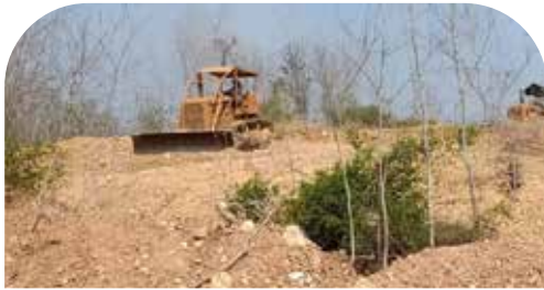
ภาพที่ 1 การดำเนินงานปรับปรุงสภาพพื้นที่ โดยเครื่องจักรกลขนาดหนัก
