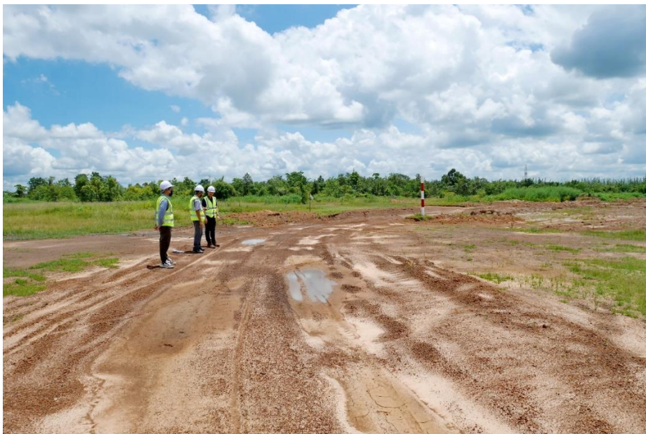
รูปที่ ๑๒ สภาพของพื้นที่ตำแหน่งปากอุโมงค์ทางเข้าเหมืองใต้ดิน
