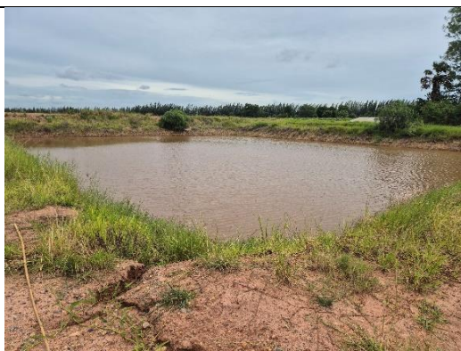
รูปที่ ๑๕ บ่อดักตะกอน
