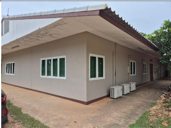
รูปที่ ๓ อาคารสำนักงาน
