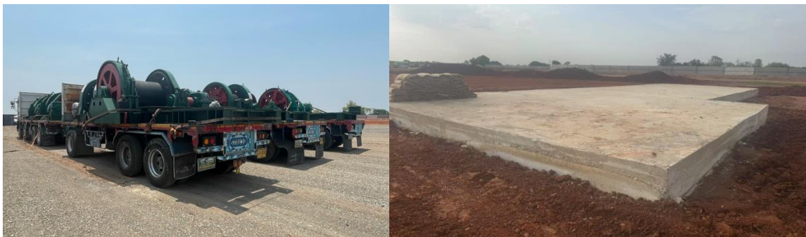
รูปที่ ๓๐ การผนึกปิดเส้นทางน้ำใต้ดิน (Grouting) และจัดเตรียมการก่อสร้างปล่องแนวตั้งใหม่
