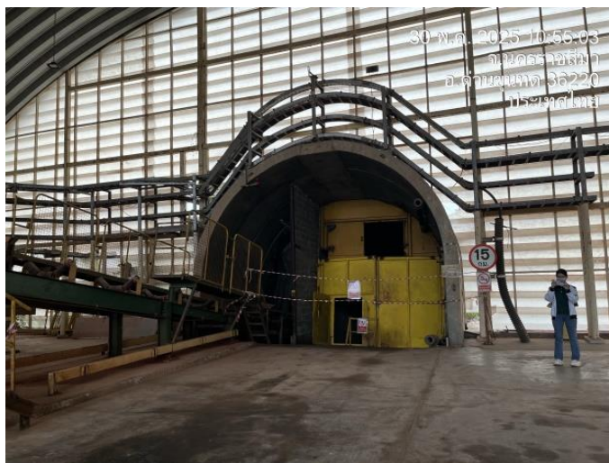
รูปที่ ๒๙ รูปแบบอุโมงค์แนวลาดเข้าสู่ชั้นแร่เดิม
