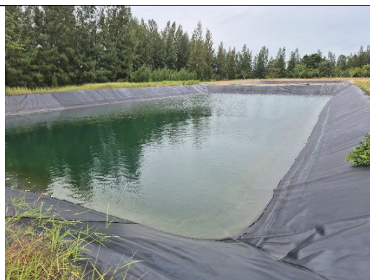
รูปที่ ๑๔ บ่อเก็บน้ำฉุกเฉิน (E)
