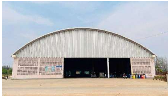
อาคารซ่อมบำรุงโรงงาน 2
