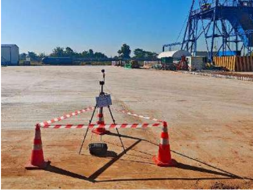
บริเวณอุโมงค์แนวตั้งใหม่
