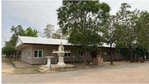
อาคารสำนักงานชั่วคราว (Office)
