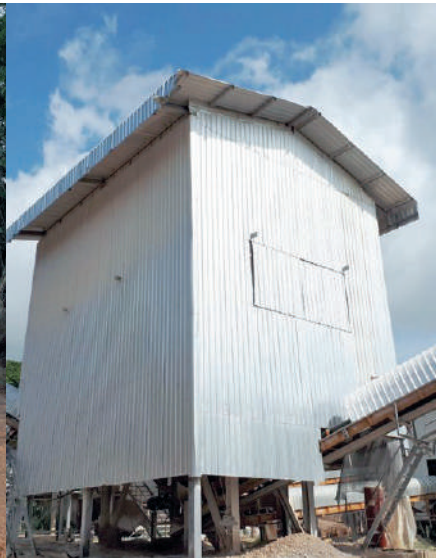
การจัดทำโรงไม่ระบบปิดเพื่อป้องกันมลพิษออกสู่ภายนอก
