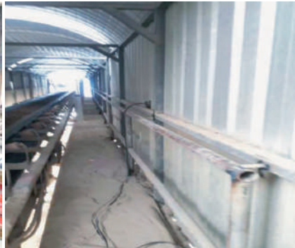
เชื่อมพื้นทางเดินซ่อมบำรุงทั้งหมด
