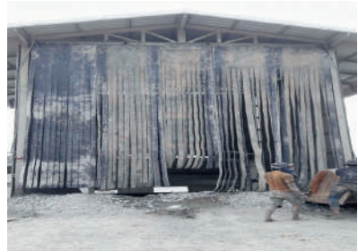
นำสายพานเก่ามาใช้ปิดคลุมปากโมเพื่อป้องกันฝุ่น
